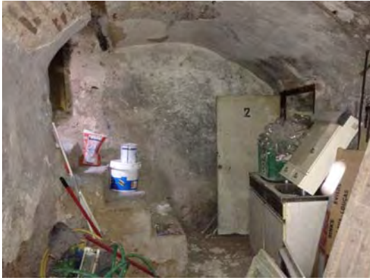
Vista del sótano bajo la crujía sur del patio, con escaleras de acceso
