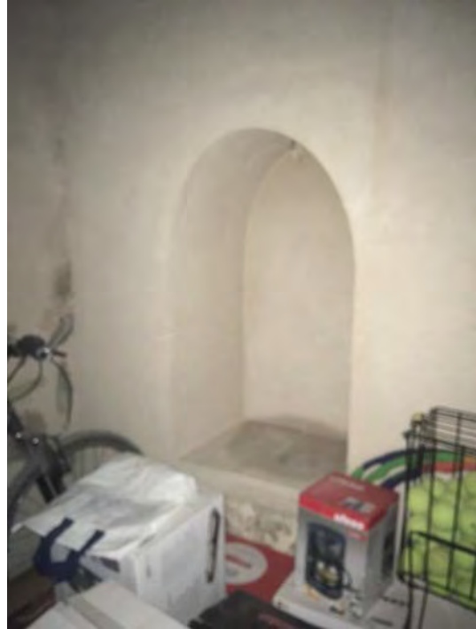
Brocal del pozo en el interior del salón este
