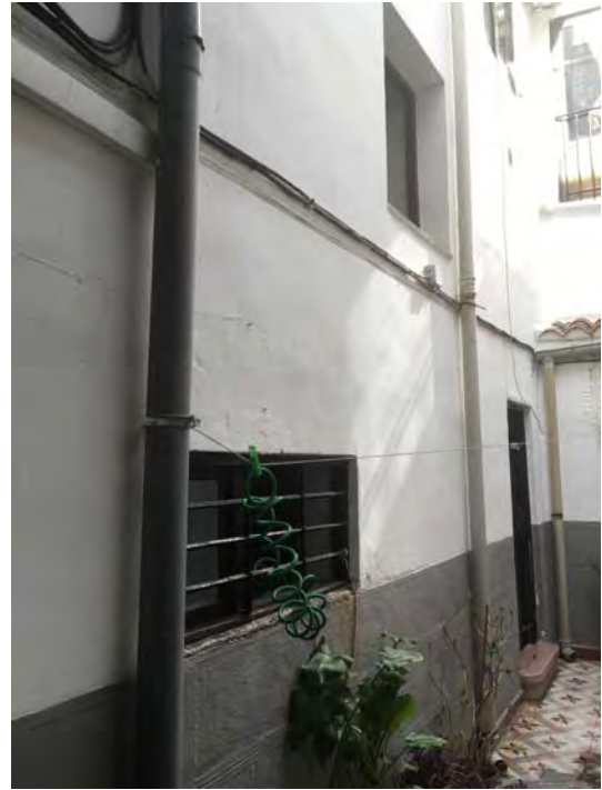
En el patio, fachada al oeste, con acceso a una vivienda.
