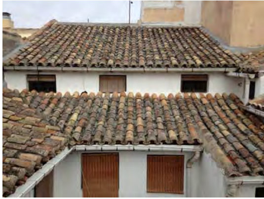
Desde la azotea ,mirando al norte, vista de las cubiertas y la parte superior del patio
