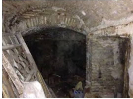
Vista del sótano bajo la crujía sur del patio, mirando al oeste
