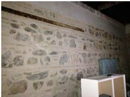
En el salón este de planta baja, pared de mampostería al este
