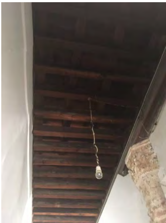
En la caja de la escalera, techo de madera y columna con capitel labrado
