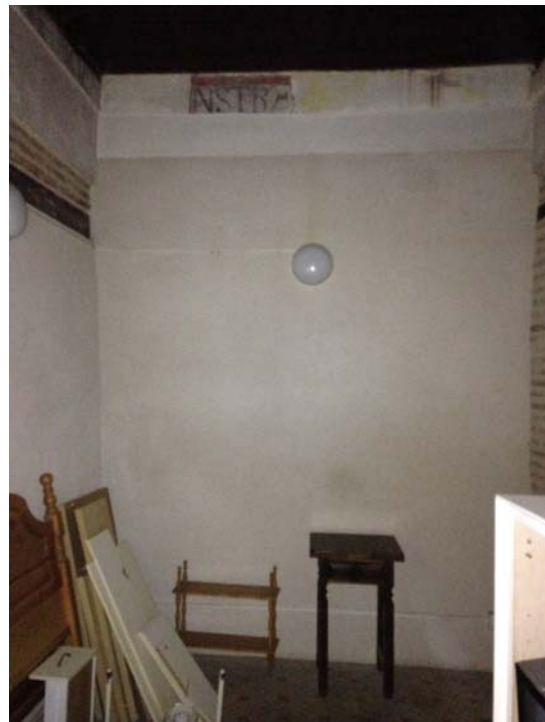
En el salón este de planta baja, pared sur con revoco de cal y nacela decorada
