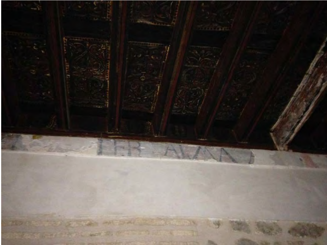
En el salón este de planta baja junto al patio, alfarje de madera policromado y nacela decorada
