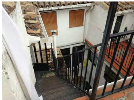
Vista de la escalera metálica de acceso a la azotea
