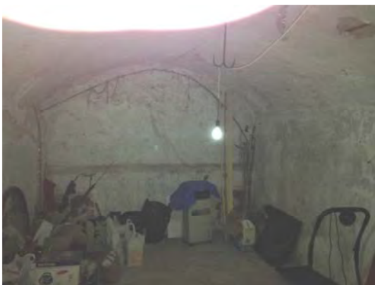
Sótano bajo el salón norte de planta baja
