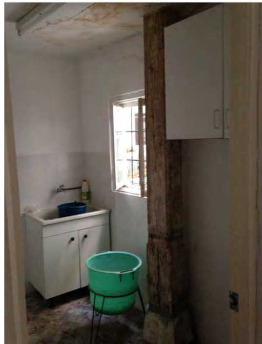
Crujía este del patio, actualmente incorporada a una vivienda. Ala derecha, pilar de madera sobre basa de granito-
