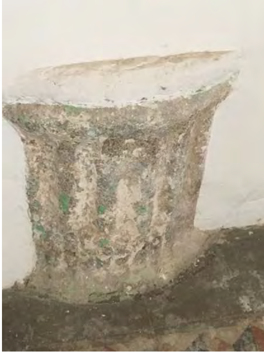
Brocal de pozo en la fachada al patio del salón este
