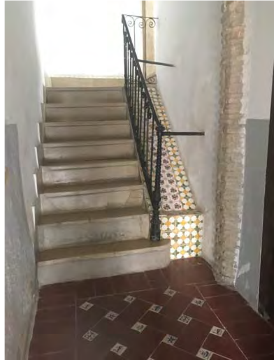
Caja de la escalera y columna del patio a la derecha
