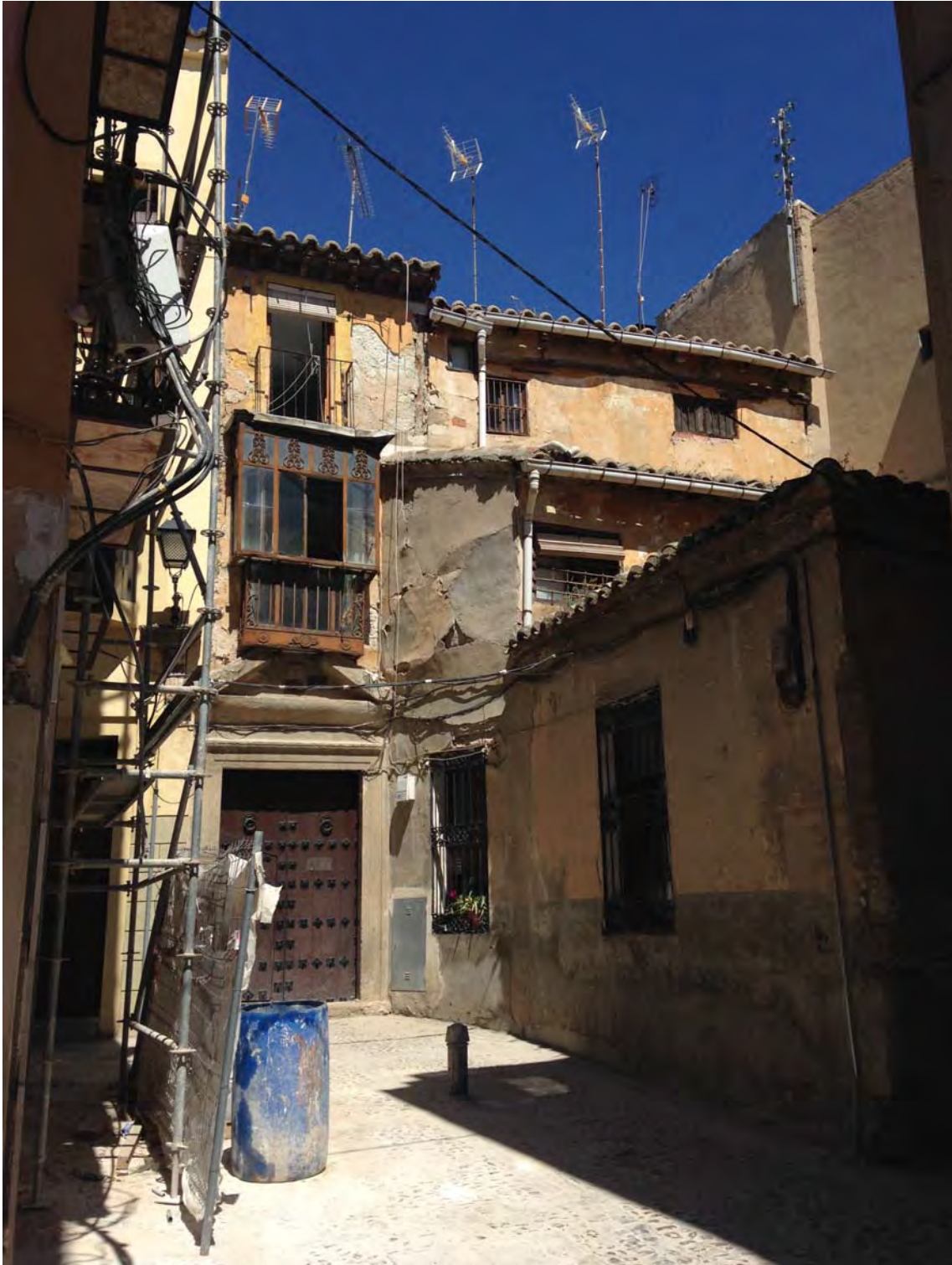
Fachada a la calle Instituto. Elementos singulares: portada de piedra, portón de madera, mirador acristalado, balcón, rejas...
